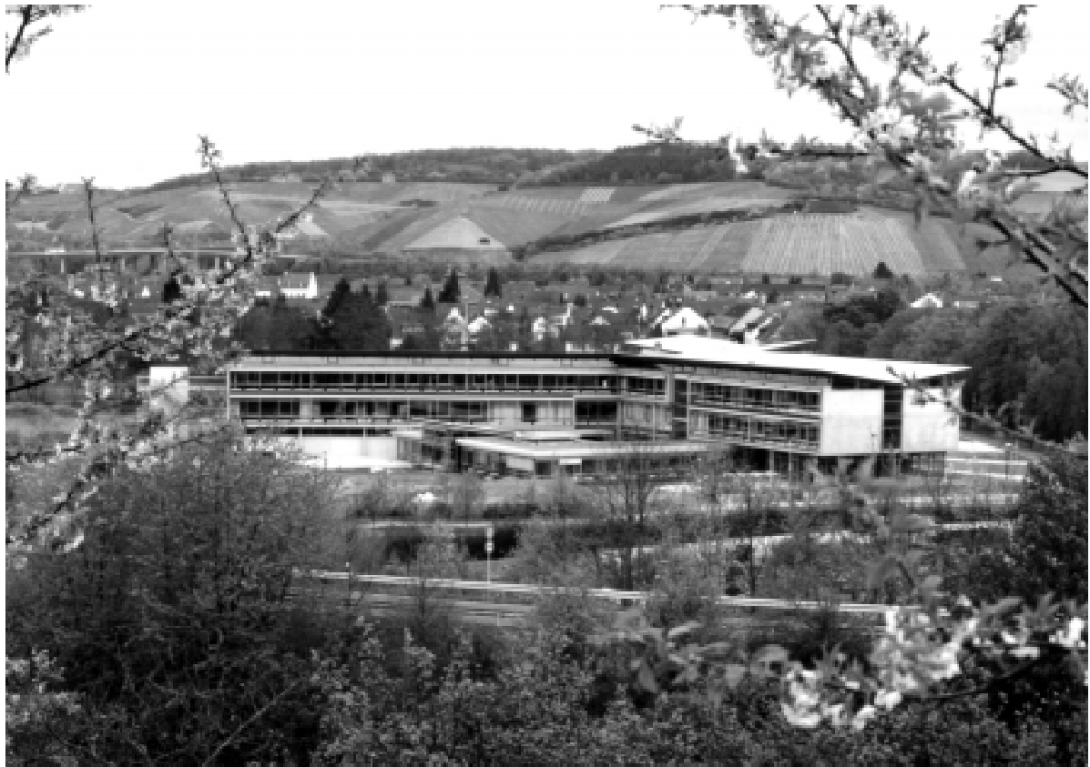
Das Peter-Joerres-Gymnasium mit Bibliotheksvorbau
